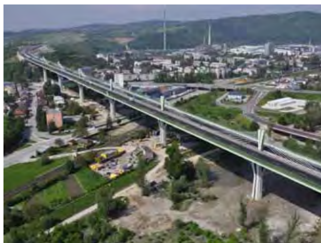
Estakáda Považská Bystrica Estakáda Považská Bystrica
